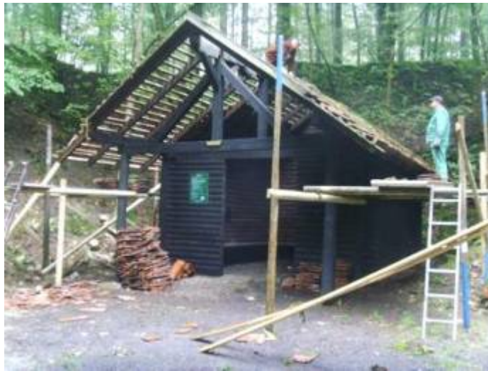
Schutzhütte Ulmenstein Nordseite bei Abdeckung der Biberschwanzziegeln
