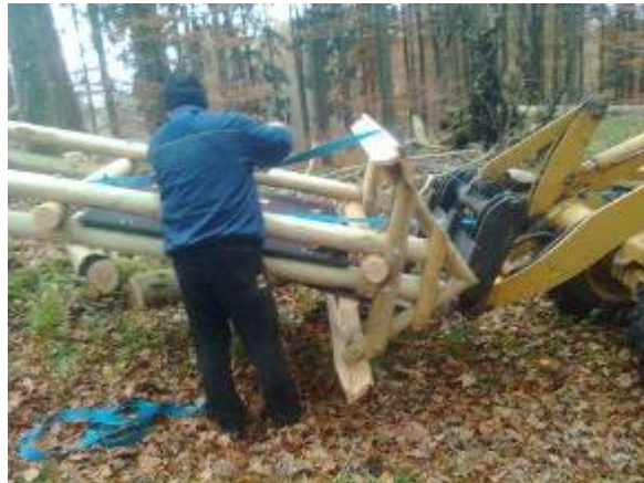
Arbeitshilfe am Stallberg durch Radlader der Gemeinde Rasdorf
